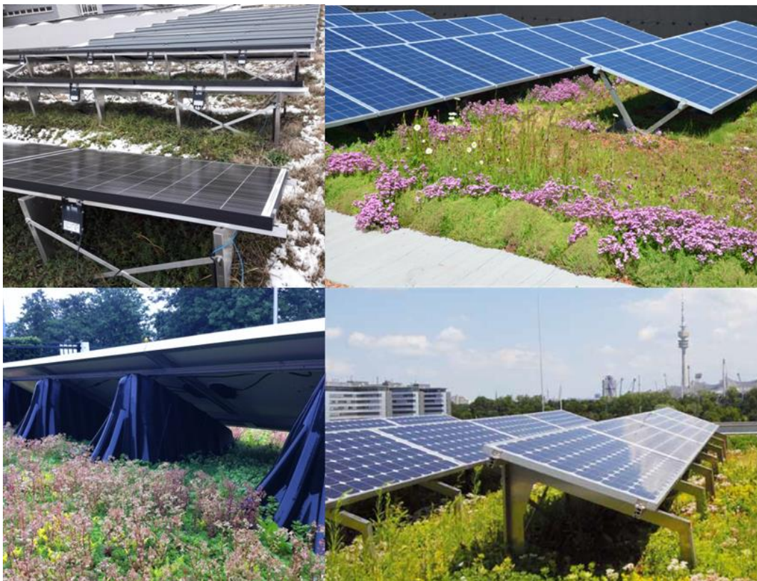
Abbildung 9 Beispiele für die sachgemäße Umsetzung eines PV-Gründaches. [27,29,41,51]
