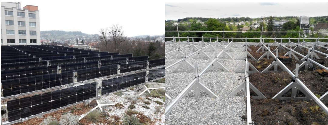
Abbildung 5 Versuchsanlage mit bifazialen Modulen und silberlaubigen Pflanzen in Winterthur (Schweiz). [32]
