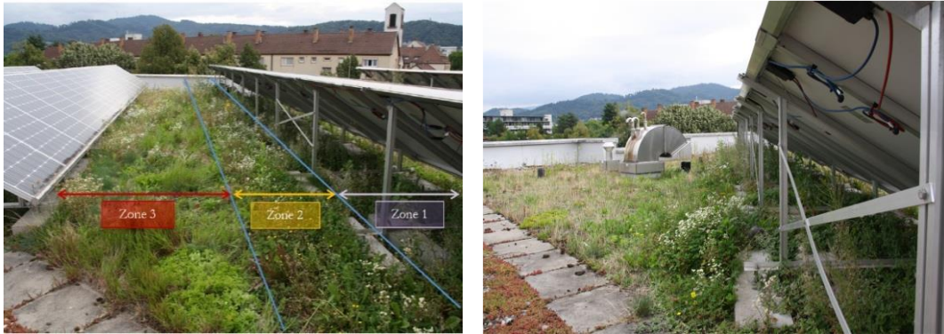
Abbildung 11 Vegetation auf dem PV-Gründach der Strahlenklinik Freiburg, die sich anhand ihrer unterschiedlichen Entwicklung in verschiedene Zonen einteilen lässt. (l.) Ausgetrocknete Begrünung auf dem Bereich des Daches ohne PV-Anlage (r.). [71]
